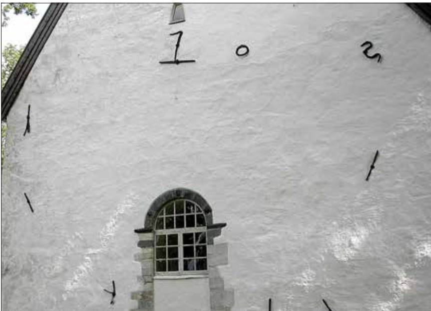
Muranker 1703. Vestveggen i Veøykyrkja. Smeden har forma fire anker til årstalet 1703 – det året arbeidet vart avslutta. (Foto Romsdalsmuseet)
