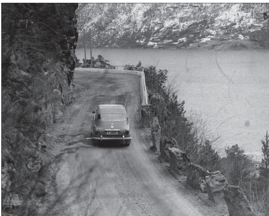
Vegen forbi Kleivahammaren var smal og uoversiktleg. Auka biltrafikk hadde tvinga fram støypt kant med rekkverk i staden for stabbesteinar. På andre sida av Eresfjorden ligg Erneset som vart fråflytta i 1969. (Foto Romsdals Budstikke/Romsdalsmuseet)
