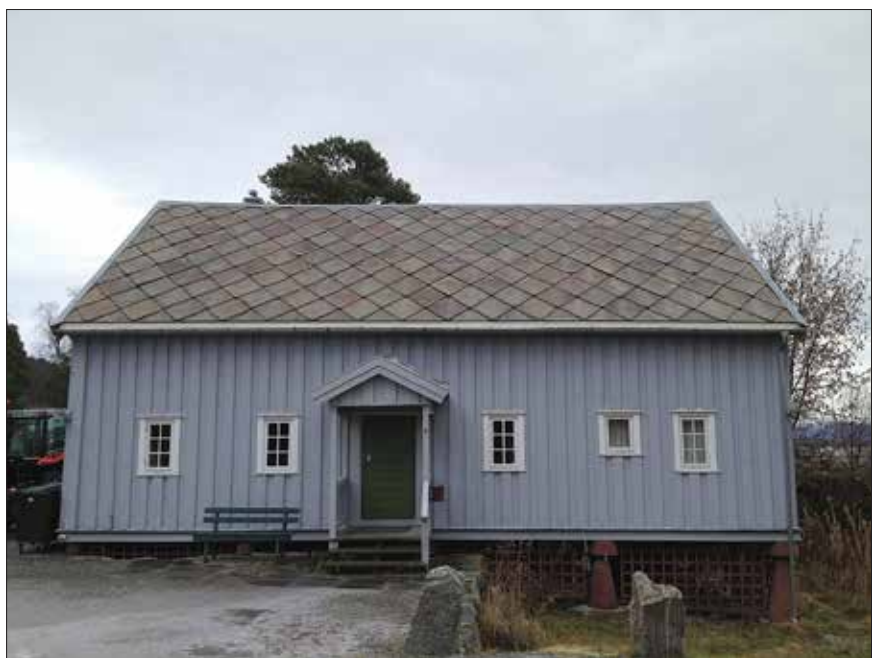
Reknesstabburet. Etter gjenreisninga på Romsdalsmuseet er vestsida tekt med store skiferhellere frå Otta. For å få nok «originalstein» til denne eine taksida vart det lagt på same sort stein frå eit uthus på Indre Årø. Dei to taka var truleg like gamle, for det var uråd å sjå forskjell på hellene. (Foto Bjørn Austigard 2013)
