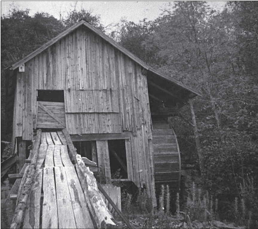
Saga sett frå sjøsida i 1950-60-åra. Ved hjelp av vasshjulet kunne ein dra tømmerstokkane opp frå sjøen. Sjølve saga måler 5 x 10,2 m, og mot sjøen er ho temmeleg høg. (Foto Romsdalsmuseet)
