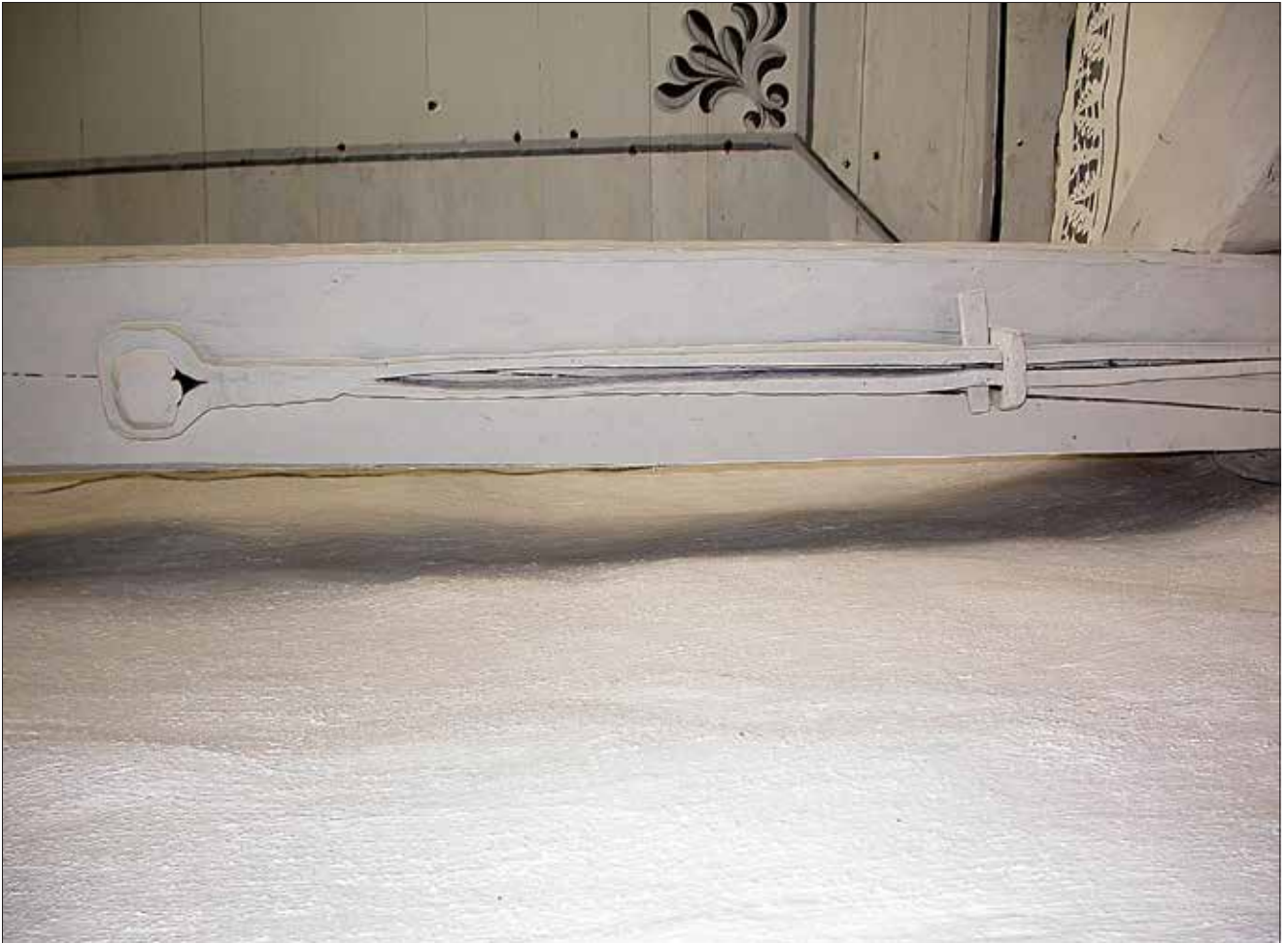
Bolt og lås. Murankeret er festa med bolt og «lås» på undersida av ein tømmerstokk som held kyrkjemurane saman. Smiarbeidet kosta meir enn 405 kg jarn kosta i innkjøp. (Foto Romsdalsmuseet)
