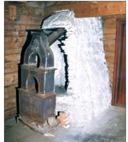
Lys-mur i gamlehuset i Olagarden, Boggestranda. Det er grue med bakaromn i etasjen under. Som bildet viser, var lys-muren berre som ei hylle i skorsteinsmuren, men det var røykkanal inn i pipa. Etter at parafinlampa kom, gjekk lys-muren ut av bruk, og det vart sett inn ein stor etasjeomnen framom. For å få røra frå omnen inn i skorsteinspipa, er «kåpa» på lys-muren delvis fjerna. (Foto Bjørn Austigard)
