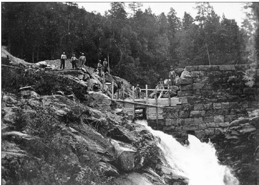
Reparasjon av flaumskade 1932. Frå reparasjonen av den nedre sperredammen i Gaudalen 1933 etter storflaumen i 1932. Denne gongen vart det forskala og støypt, ikkje mura med naturstein slik som første gongen. (Foto utlånt O. Husby/Sunndal kommune, FylkesFOTO-arkivet 2013)
