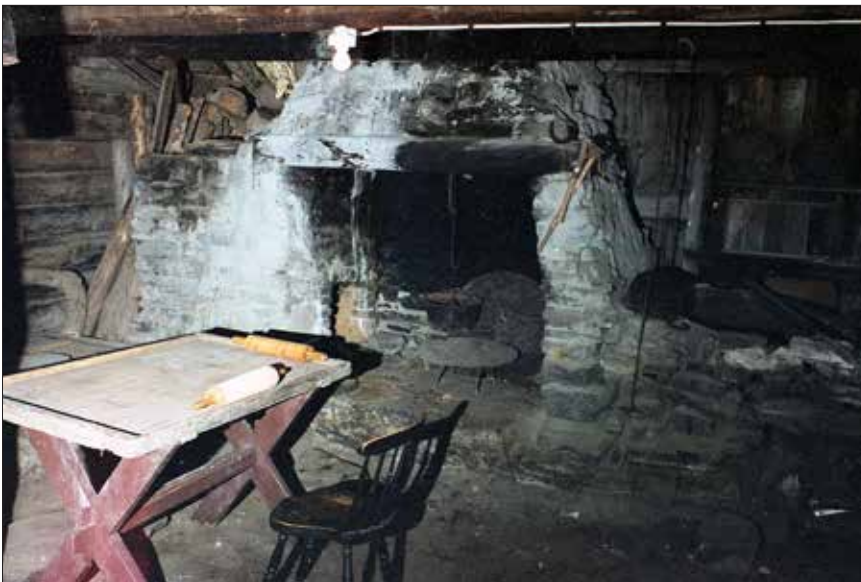
Grue i eit eldhus på Nauste. Bakaromnen er t.v., og storgryta til t.h. I den innmura gryta tørka dei korn, vaska klede, koka såpe mm. I Romsdal var dette ei svært vanleg løysing. Bakaromnen vart fylt med tørr ved og deretter tent på. Når det meste var brunne ut, kosta dei ut glør, kol og oske. For å kontrollere om varmen var høveleg, kasta dei ein liten neve med mjøl inn i omnen. Vart mjølet jamt brunt på eitt minutt, høvde det å setje inn brøda. (Foto Bjørn Austigard/Romsdalsmuseet)
