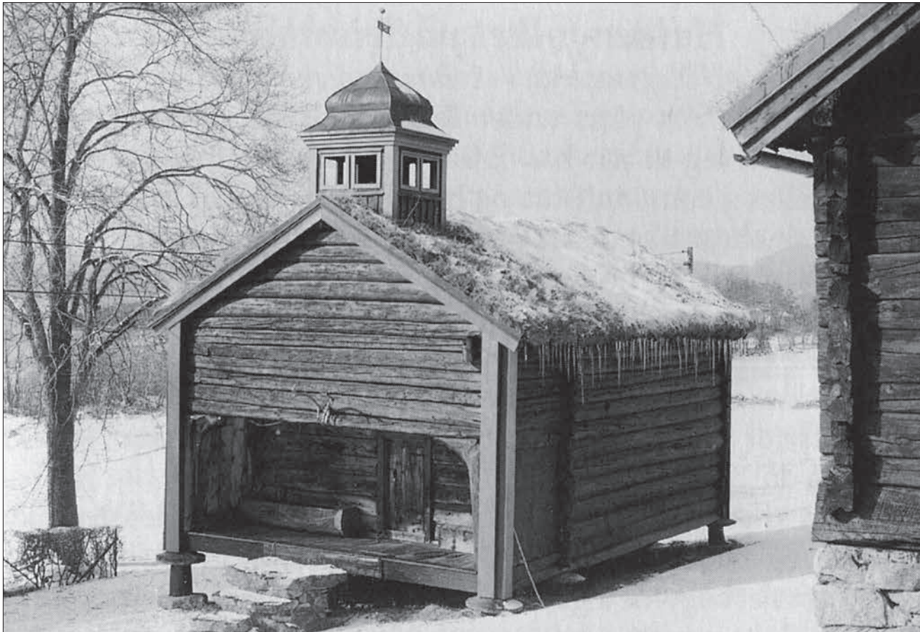
Gjestestua på Teiset tenestegjer i dag som stabbur på Søsnes. Huset vart først selt til Åram, men i 1938 kjøpte konsul Jonas Lied stabburet og sette det opp på garden sin. Tømmeret er hogd i 1620. Innvendig er det mange merke i tømmerstokkane etter veggfaste senger. (Foto Bjørn Austigard/Romsdalsmuseet)
