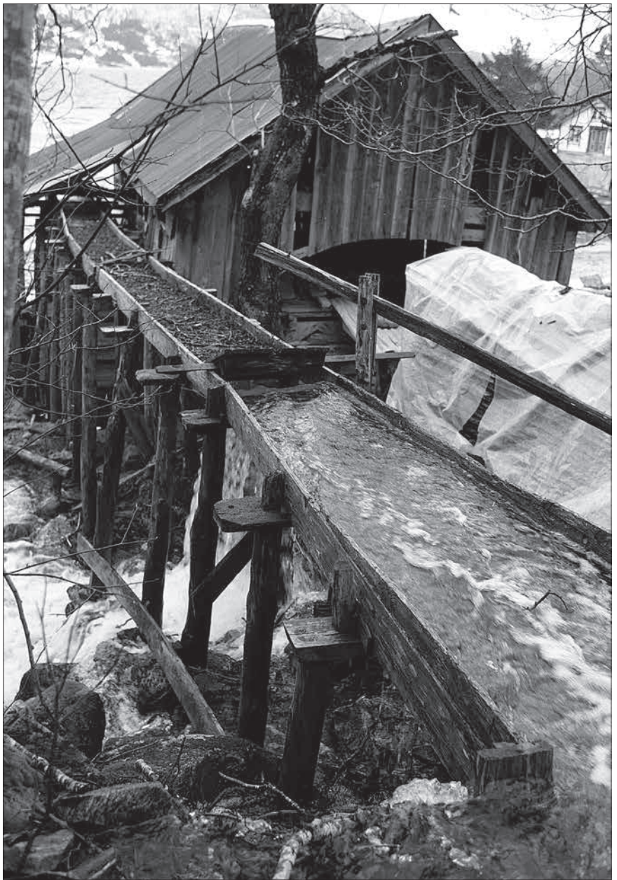
Hestadsaga med vassrenna. For å få vatnet inn på vasshjulet, måtte det til ei lang og kraftig vassrenna. Når dei skulle stoppe hjulet, løfta dei opp ei luke i renna («demnmå»). All kvisten og lauven i nedste del av renna viser at det er lenge sidan det rann vatn inn på hjulet. (Foto Romsdalsmuseet)
