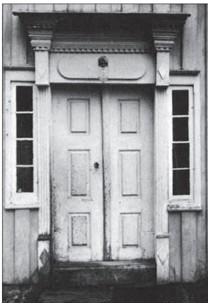
Inngangspartiet i Lensmannsgarden, Austigarden, Øvre Myklebostad. Huset vart bygd ein gong mellom 1837-43. Dørkrona over døra og dei flate søylene på kvar side, er sterkt inspirert av stilarten empire. (Frå «Arkitektonisk kartlegging av den eldre bebyggelse i Møre og Romsdal, 1975».)
