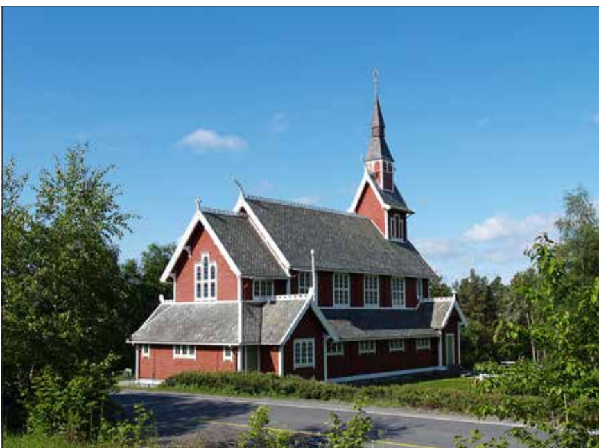
Vøy nye kyrkje på Solsnes. Drakestilen og stavkyrkjepreget er lett å sjå. (Foto Erling Neerland/Romsdalsmuseet)
