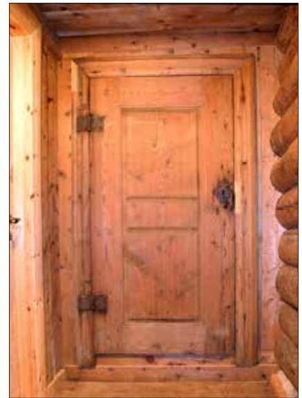
Gammal fyllingsdør med breitt listverk. Døra kjem frå Sjarmyra, Sandnes, men er no brukt oppatt i staburet mitt i Eikesdalen. Døra har berre eitt felt, men to høvla spor midt på døra «illuderer» tre felt. (Foto Bjørn Austigard)
