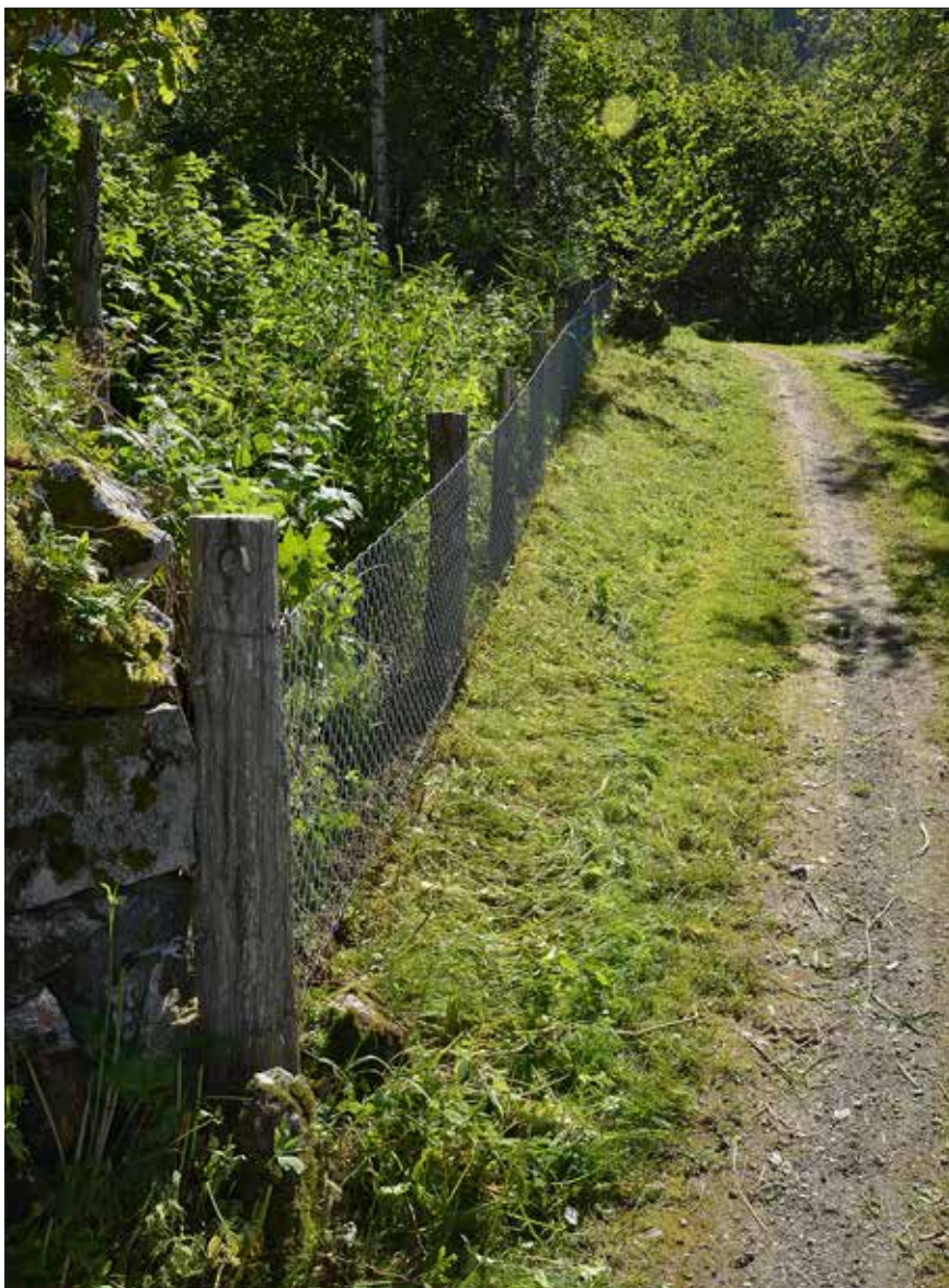
Gjerdestolpar av eine. Her har artikkelforfattaren kombinert einestolpar med flettverksgjerde. (Foto Sigmund Austigard)
