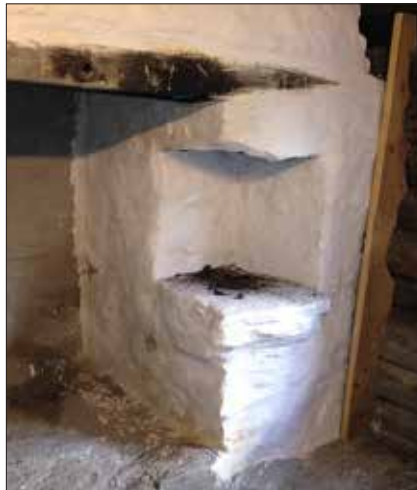
Lys-muren i eldhuset i Oppigard er ein del av den store grua t.v. i bildet. Røykkanalen frå muren går inn i skorsteinspipa høgt oppe. (Foto Bjørn Austigard)
