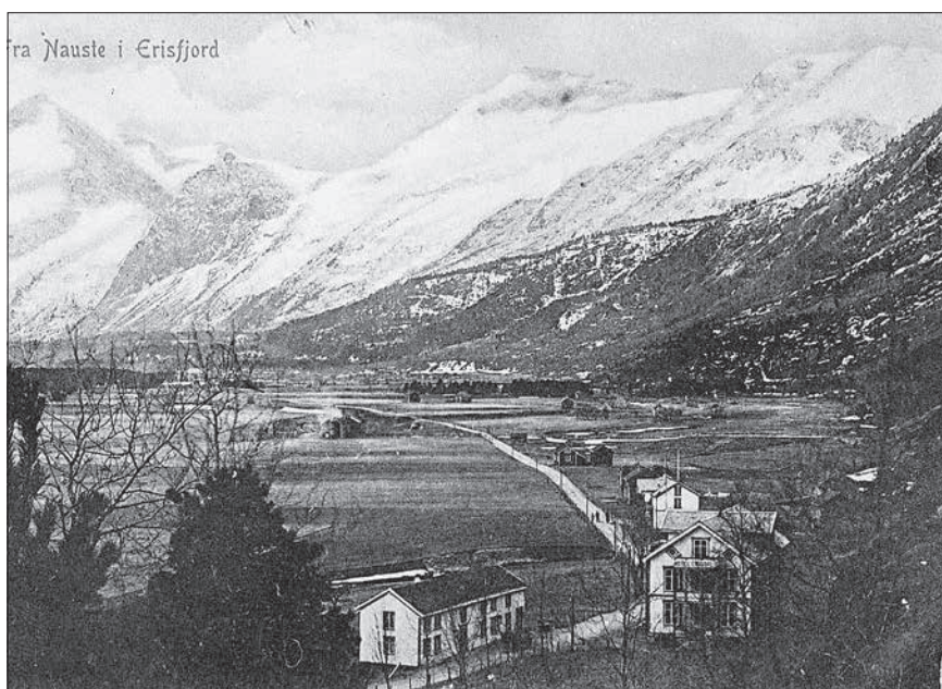
Nauste sett frå 17-maihammaren kring 1914. Aura Landmandsbank opna kontor i Hotel Eikisdal (t.h.) (Foto utlånt frå NE/Romsdalsmuseet)
