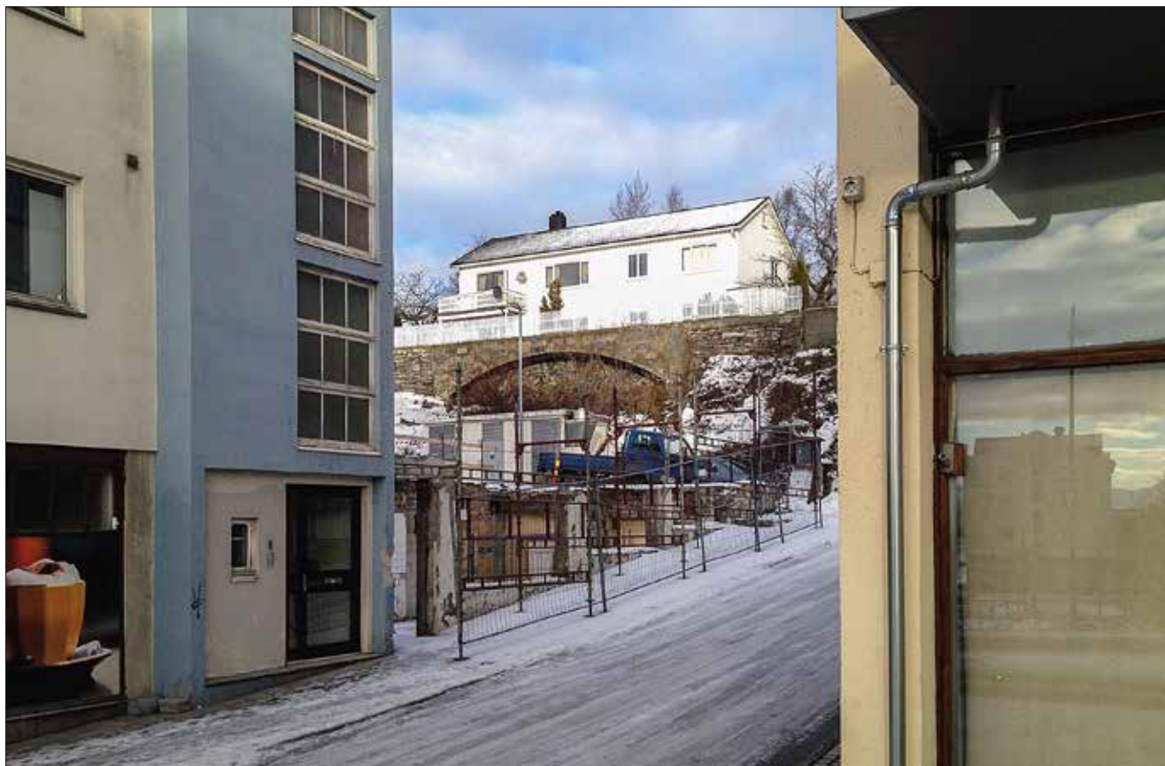
Steinkvelvingen i Kirkekrøpet var godt synleg mellom Storgata 57 og Romsdalsgata 1 våren 2013. Sørenden av den gamle rådstua/Solemdalhuset kvilte på denne kvelvingen i nesten 80 år. Berre grunnmuren av den gamle bakeribyginga frå 1917 står no att. (Foto Bjørn Austigard februar 2013)
