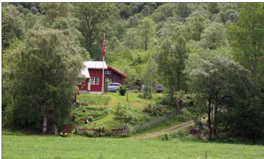
Det gamle stabburet har ny, tjørebredd bordkledning utvendig, men innvendig er dei gamle tømmerveggene synlege overallt. (Foto Bjørn Austigard, 29. mai 2011)
