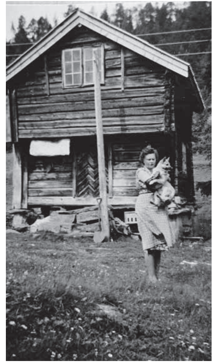
I Nordigarden på Skjørsetra, er loftet bygd fram over stabburdøra. Dette var temmeleg vanleg. (Foto Romsdalsmuseet)
