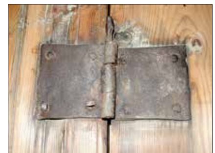
Opphavleg dørhengse og lås på døra frå Sjarmyra. (Foto Bjørn Austigard)
