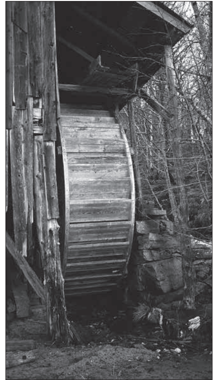
Overvasshjulet har ein diameter på 4,2 m, og det er 1,23 m breitt. Hjulet vart tjørebredt av og til for at det skulle halde seg. Hjul-åsen kviler i eit steinlager på bae sider, og dette vart smurt med fiskelever (lyse) i gamle dagar. (Foto Romsdalsmuseet)
