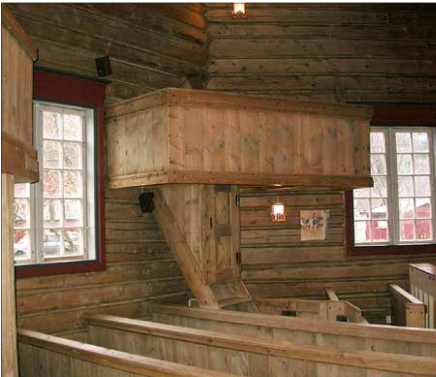
«Jordmorskreppa» i Ålvundeid kyrkje. Dette vesle galleriet vart sett opp etter at kyrkja var ferdig. På den måten fekk jordmora i soknet eigen plass i kyrkja. (Foto Bjørn Austigard/Romsdalsmuseet)
