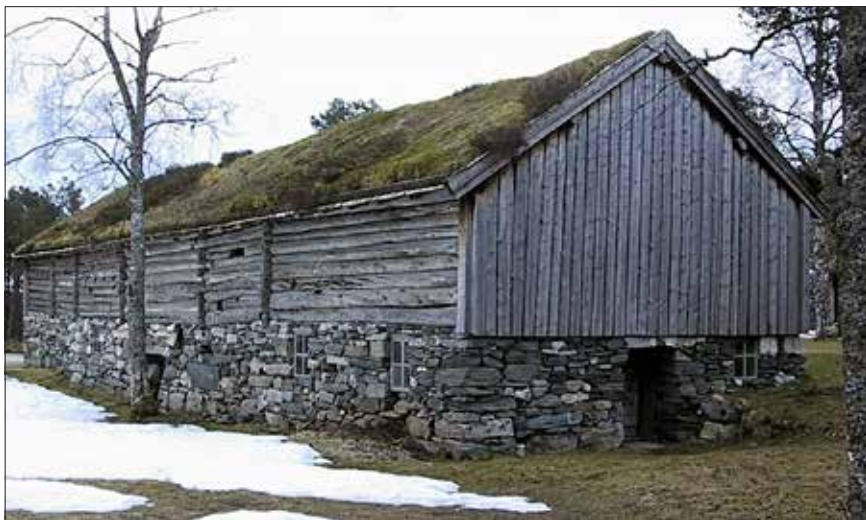
Hammervolløa før og etter flyttinga. Når ein ser bort frå at løa no har torvtak og at dasset ved stallnova manglar, er likskapen før og etter flyttinga svært god.
