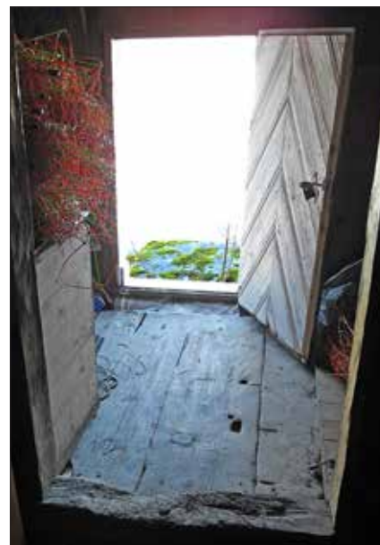
Frå stabburgangen på stabburet i Larsgarden, Nedre Myklebostad. Dørholet måler berre 74 x 140 cm. Døra er ei typisk stabburdør med fiskebeinsmønstra kledning på utsida, men ho er svært smal i høve til standarden på 16- og 1700-talet. (Foto Bjørn Austigard)
