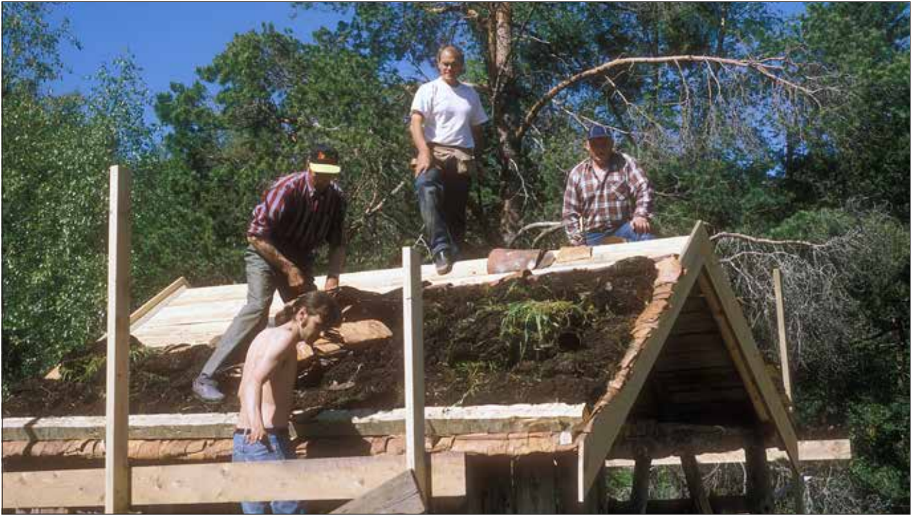
Det er viktig at torva blir lagt rett. God torv må til. Det er den som held nevra på plass. På taket: Jon Møkkelgård, Lyder Hesthol og Ola L. Løfaldli. På stillaset: Håkon Tofte. (Foto Bjørn Austigard/Romsdalsmuseet)
