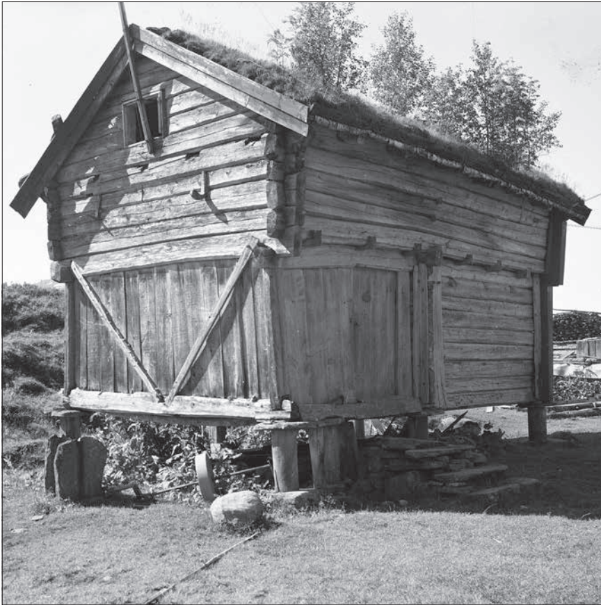
Stabburet på Skalle, Kleive, før det vart flytta til Romsdalsmuseet 1949. Her er tømmerdelen i første etasje frå ca. 1700, medan stabbursvala og loftet er frå 1800-talet. Stabburloftet er ca. 25 cm breiare på kvar side enn gammel-stabburet. På den måten fekk dei meir plass, og det vart tørrare kring veggene. (Foto Romsdalsmuseet)
