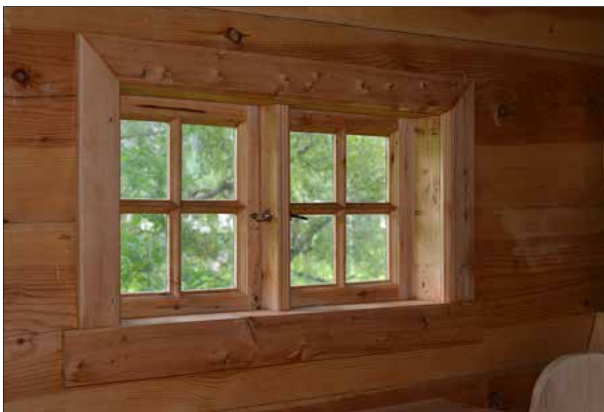
Vindu av eine. Her har eg laga glasrammer, glaskarm og omramming innvendig av eine, utan å lime saman delane. (Foto Bjørn Austigard)
