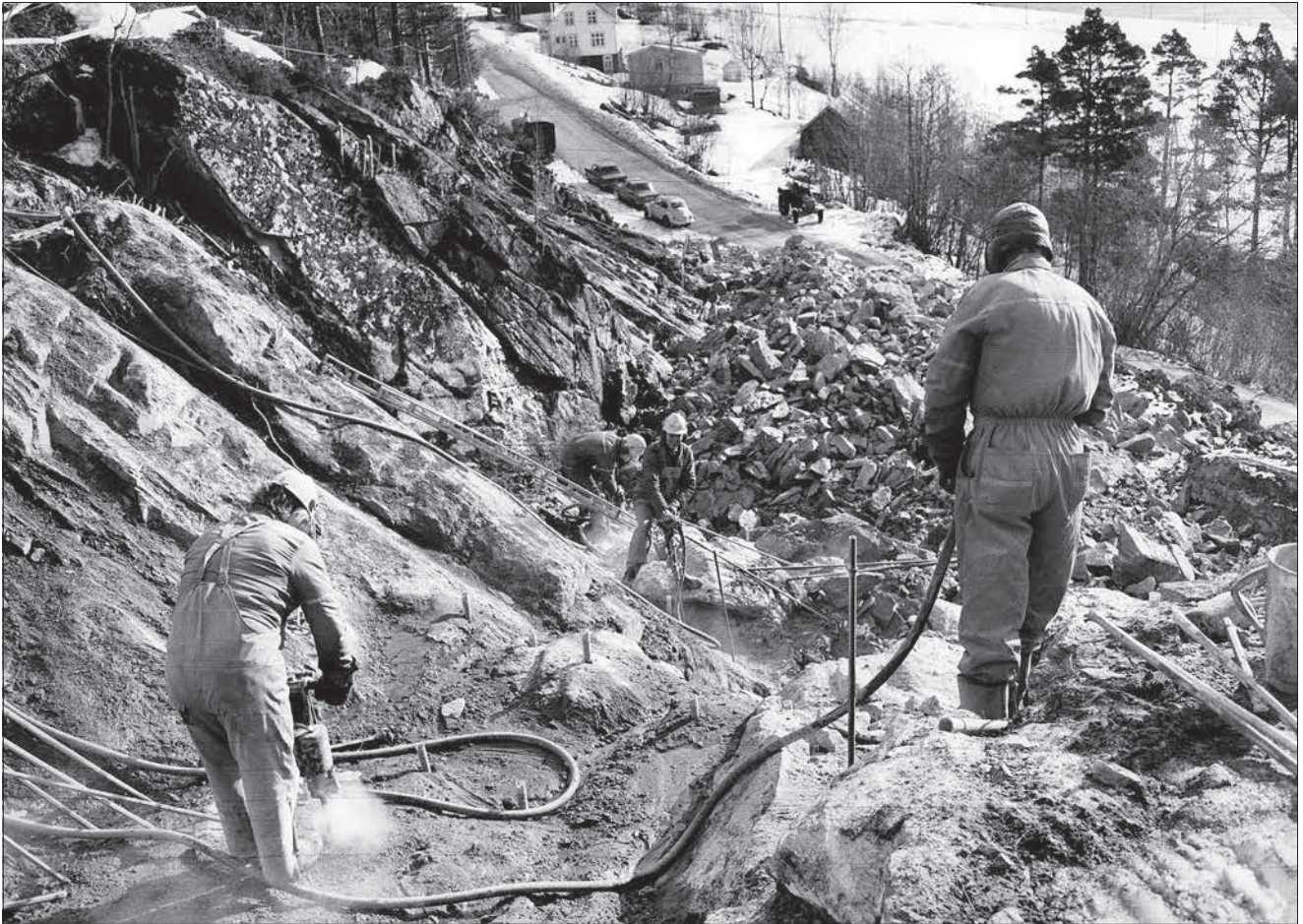
Frå arbeidet med «innslaget» til tunnelen. Tre mann borar for hand ute i friluft. Borehola står tett. Skinnhua var både varm og støydempane. (Foto Romsdals Budstikke/Romsdalsmuseet)
