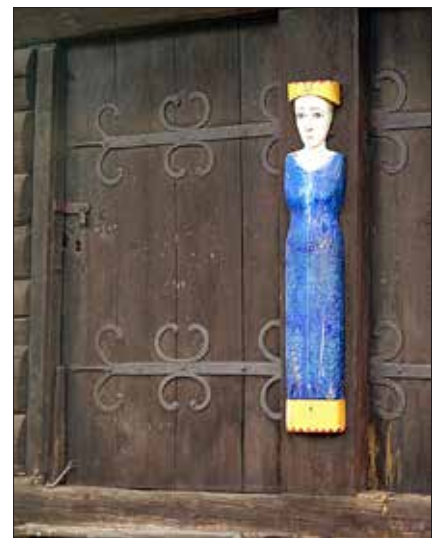
Dørhengslene («gongejarna») på storstabburet på Ner-Monsås er høgst rimeleg smidd av stongjarn frå Lesja. (Sjå side 212) (Foto Bjørn Austigard)
