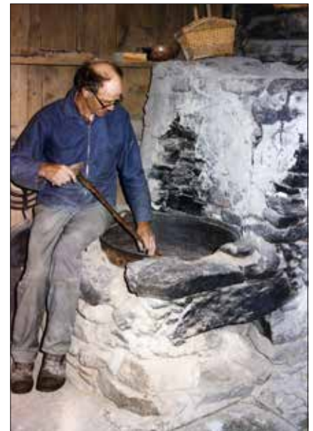
Håkon Vike ved storgryta på Vikehaugen på Vike. Bakaromnen er inni den store gråsteinsmuren t.h. Med gode røykkanalar lét det seg gjere å varme opp både gryta og bakaromnen. (Foto Brit Vike/Romsdalsmuseet)
